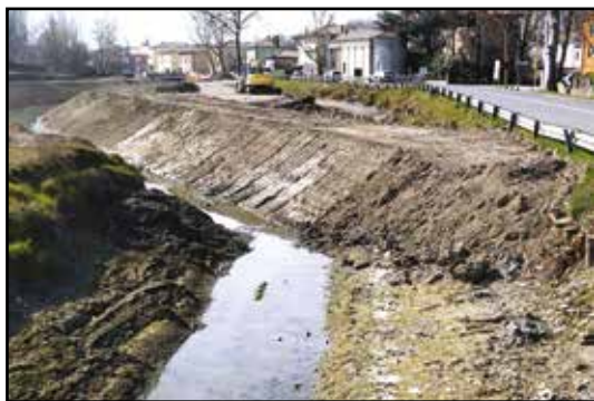
Il canale dopo la deviazione
