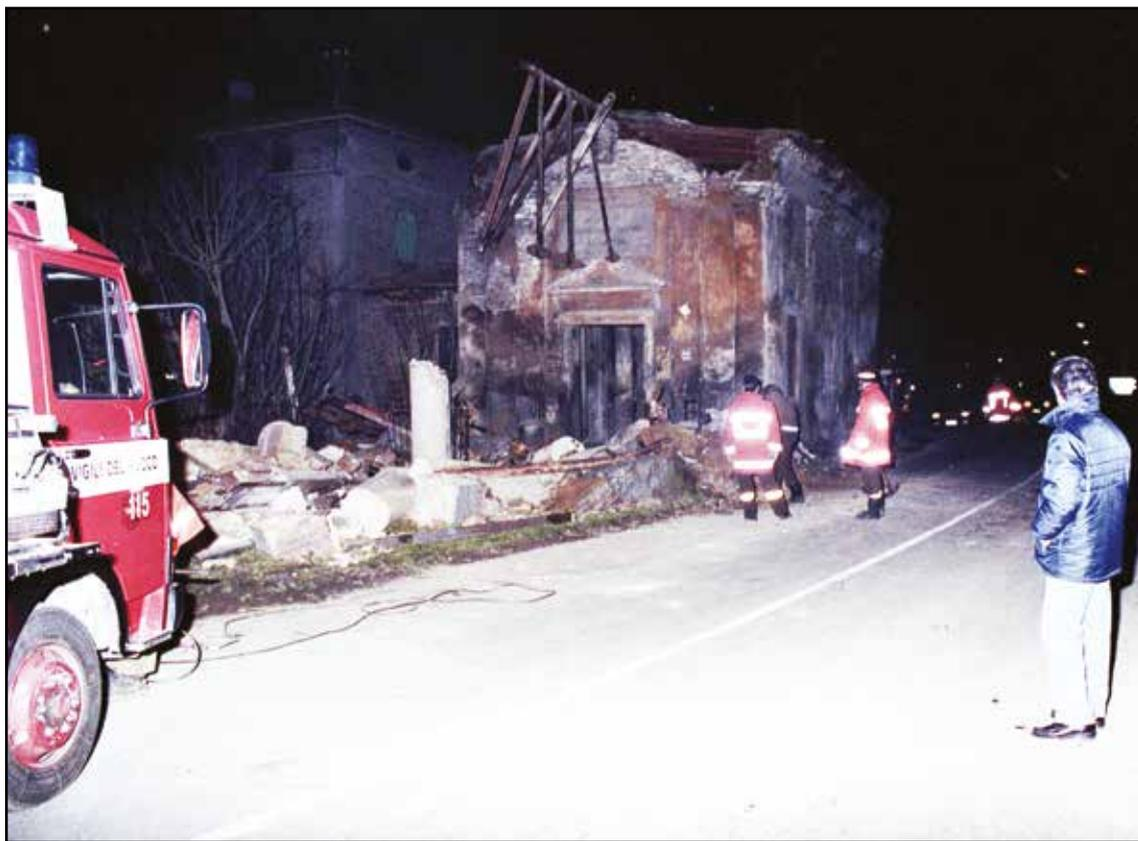
8 aprile 1992 ore 21,30- La parte anteriore del Chiesolino (colonne e tetto del pronao) è stata appena abbattuta; in primo piano l'automezzo dei vigili del fuoco e il cavo d'acciaio che sono serviti per l'abbattimento...
