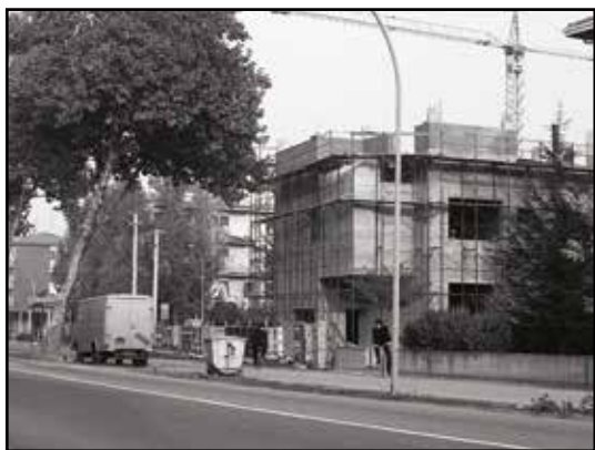
1982: Il Centro Civico in costruzione 1985: Inaugurazione del bar della Pieve
